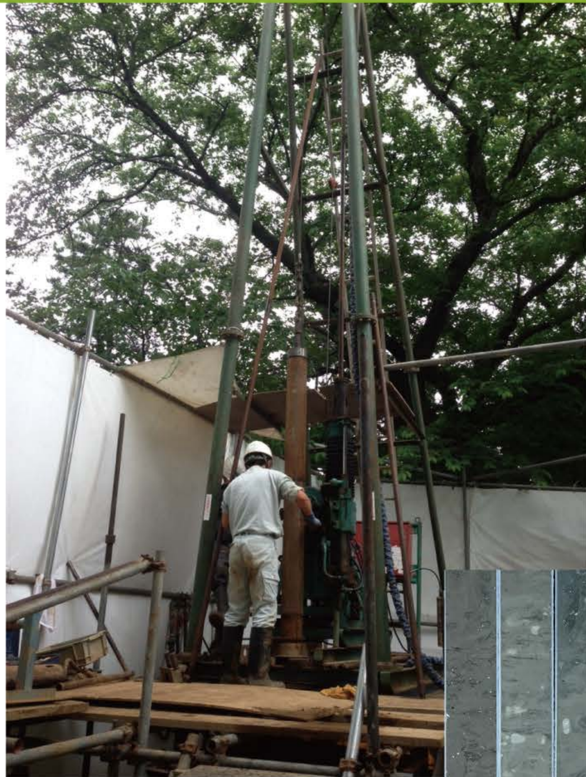
ボーリング調査
