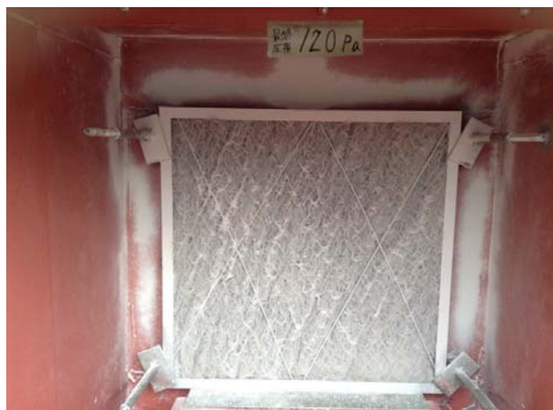
写真-66 圧力損失 120Pa
