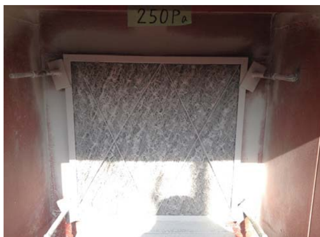
写真-69 圧力損失 250Pa
