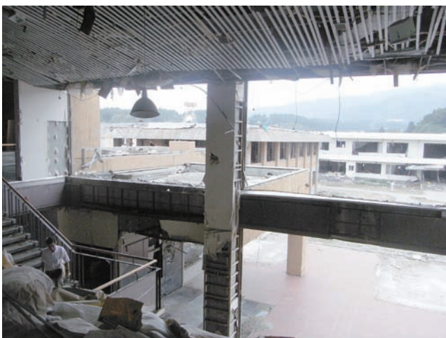
図1 被災した陸前高田市立博物館の内部。二階天井も浸水し、漂流物が残されている。
