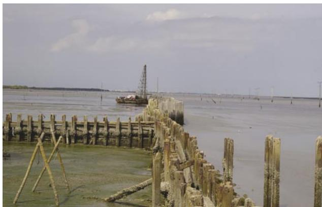
写真2 寺院を侵食から護るために作られた防御杭。向こうに見えるコンクリートの新しい杭が、今年作られたタナワット (Thanawat Jarupongsakul) 准教授による防御杭。防御杭の左側の陸側では2ヵ月間に30cmの堆積が確認されている。右側沖合に見えるのは、かつてこの付近一帯が陸地だった頃の水路沿いに建てられた電柱列。現在は海中に林立している。
