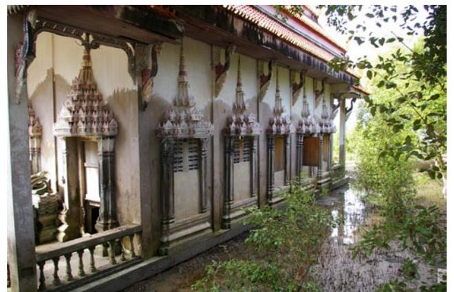
写真 1 地盤沈下によって沈水している寺院 (Ban Khun Samutchin)。沈水から免れるため床が約 1m 上げられている。本来の床は、現在床下であり、高潮時に沈水し僅かに土砂が堆積している。境内は 40 ~ 50cm 土砂が一面に堆積し、本堂に入る階段が 3 段、現在の地面に埋もれている。
