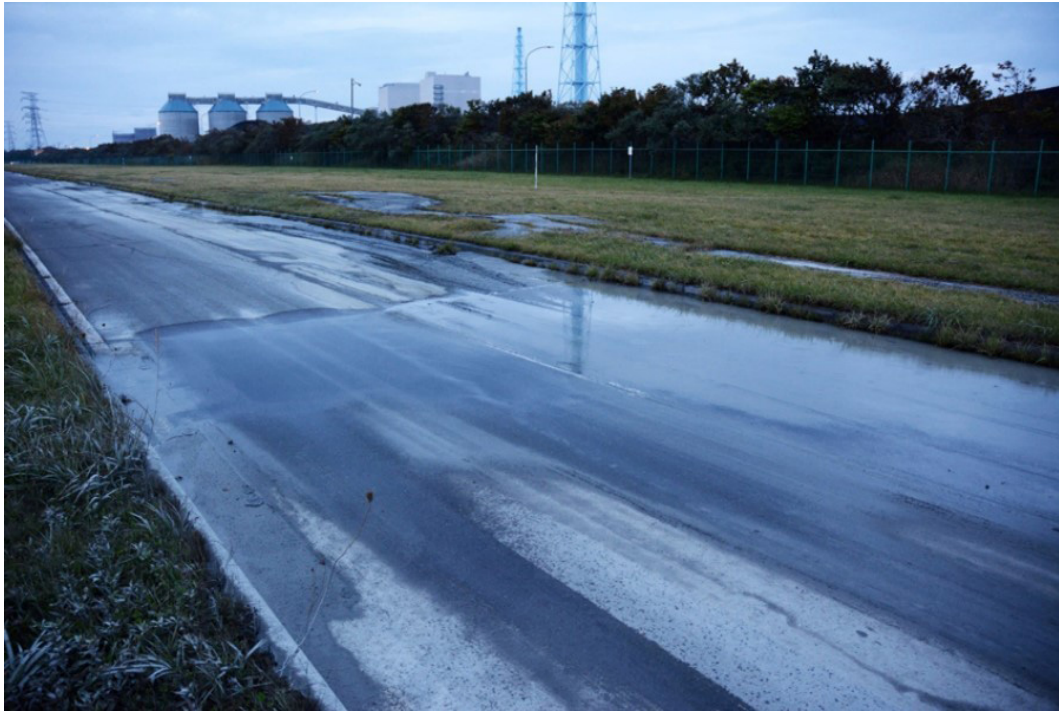
第4図 液状化による噴砂と泥水。 水たまりになっている箇所がみられるが、それ以外の箇所も道路上に泥水の乾燥した跡が広がっていることから、地震直後は噴出した泥水により広く冠水していたことが推測される。東側車線。
