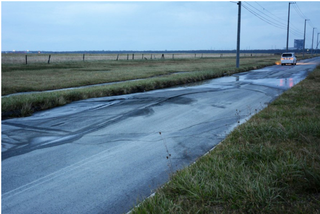
第5図 液状化による噴砂と道路の波状変形。 第4図とほぼ同地点の西側車線。
