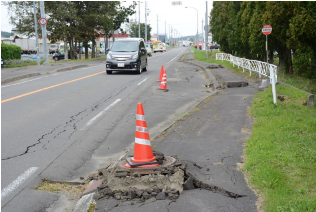
第 7 図 液状化によると思われるマンホールの抜け上がりと道路の変形。
