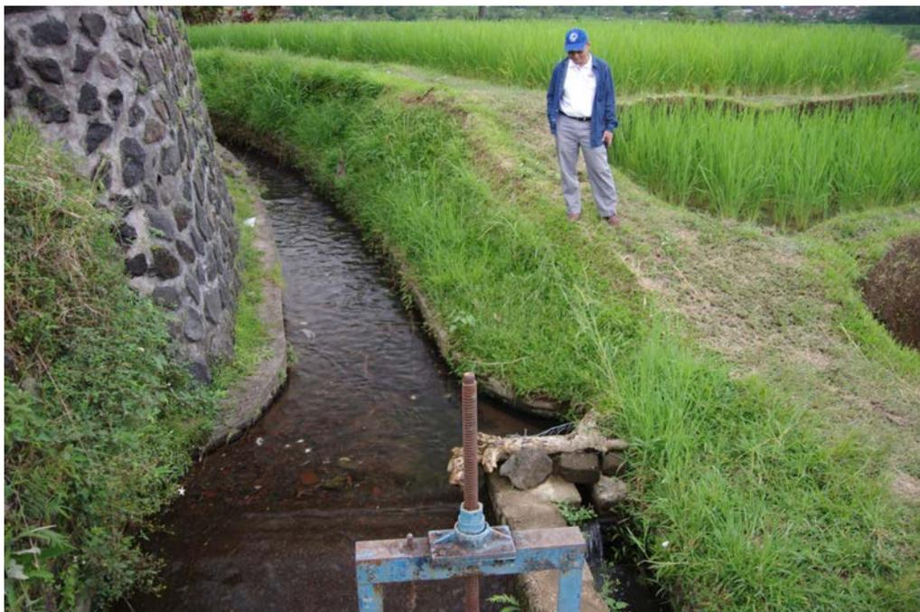
写真3 ジャティルウィの棚田でみられるスバック灌漑システムの水路と分水堰。
