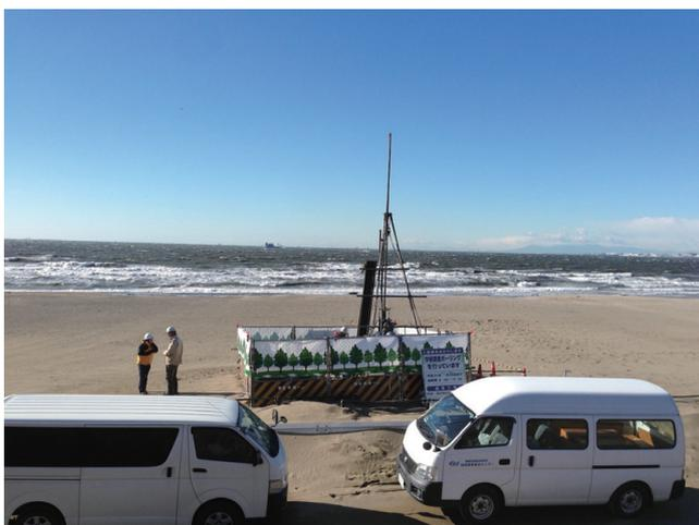
第1図 ボーリングの掘削風景。千葉マリスタジアムの南側の砂浜。標高はTP 3.9 m、ボーリングの掘進長は40.3 m。この付近一帯は埋立地であり地表から深度10.75 mまでは人工地層からなる。沖積層の基底は深度37.55 mに確認された。
