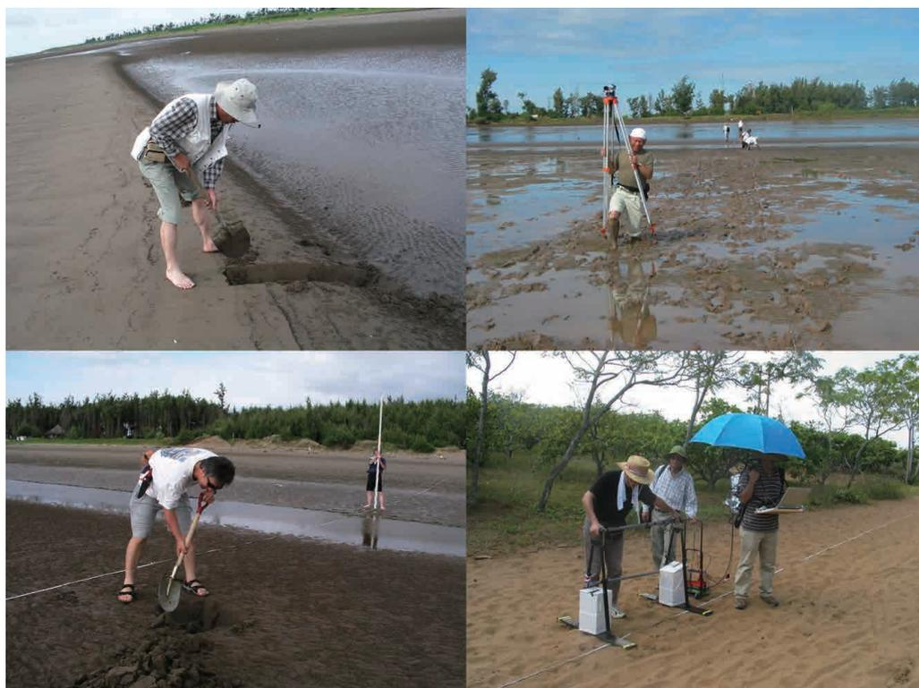
第 8 図 チャービン省バードン海岸での測量と堆積物調査, GPR 調査。
