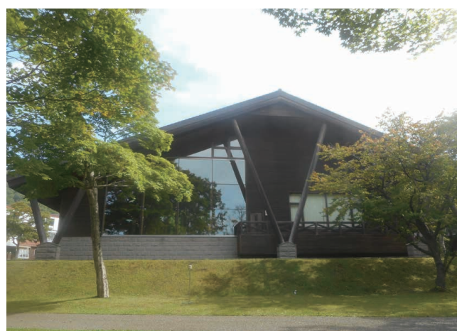
第3図 支笏湖ビジターセンターの外観。建物の左側に大きいガラスの三角窓がある。
