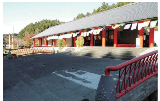
第1図 天平ろまん館の近景。写真の左端が黄金山神社の参道の入り口にある鳥居。
