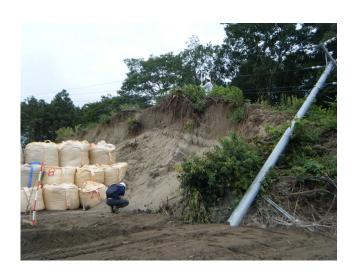
写真 2 常総市若宮戸地区における河畔砂丘の高まり. 越水の影響で電柱が東側に傾いている.
