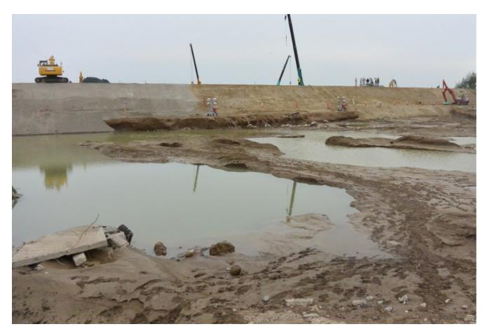
写真6 常総市三坂地区の破堤箇所直近に形成された侵食地形(落堀).破堤箇所には水害後の工事により仮堤防が造成されている(写真奥).
