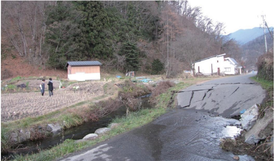
写真1 白馬村塩島集落にみられる地表地震断層. 写真は北東へ向かって撮影. 廣内ほか(2014)により, 西側低下の上下変位約90cmが報告されている.
