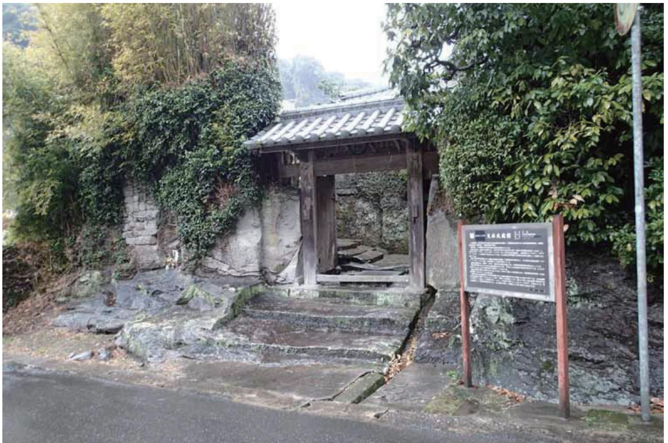
写真3 シラスの溶結部を巧みに使った天水邸の門。江戸中期に構築された代表的な薩摩庭園(志布志市志布志町)。
