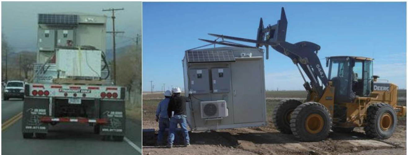
写真 12 重力計測小屋は別の調査候補地点に設置していたものを移設した。重力計測小屋自体の可搬性を確認できた。1回の給油で1か月連続運転可能な自家発電システムも一緒に移設した。
