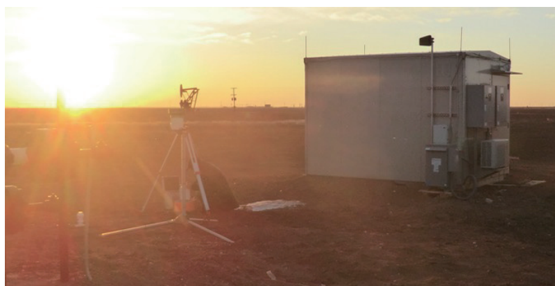
写真1 ファーンズワースではCO 2 注入による石油生産増産効果も狙う実証試験が行われる。石油井が点する調査サイトに重力計測小屋 iHut を設置した。地形は極めて平坦で、起伏のない地平線から朝日が昇る。
