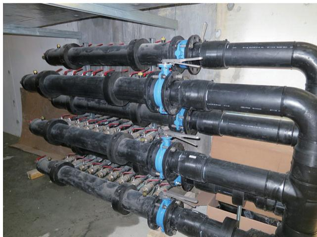
写真3 写真2のビルディングの地下に設置されたGHPシステムの配管の一部。30本のBHEから集められた循環液がここで一つにまとめられ、ヒートポンプへ送られる。
