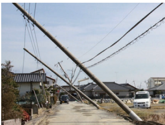
電柱の被災状況.
