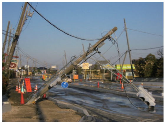
電柱の被災状況.
