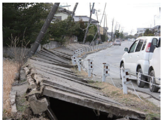
水路の被災状況.
