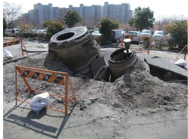
マンホールの抜け上がり（浦安市高洲中央公園）.
