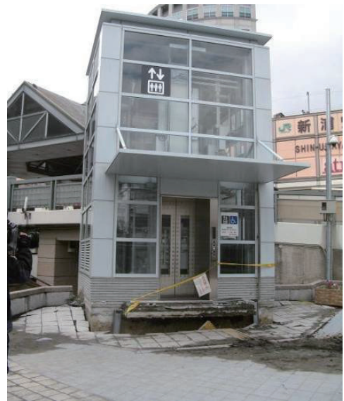
エレベータホールの抜け上がり（JR新浦安駅前）.
