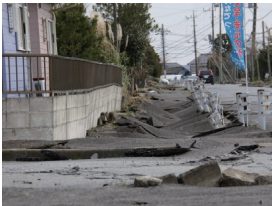
歩道の被災状況.
