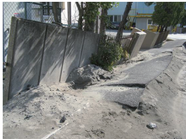
噴砂と道路・ブロック塀の被害（浦安市鉄鋼団地）.
