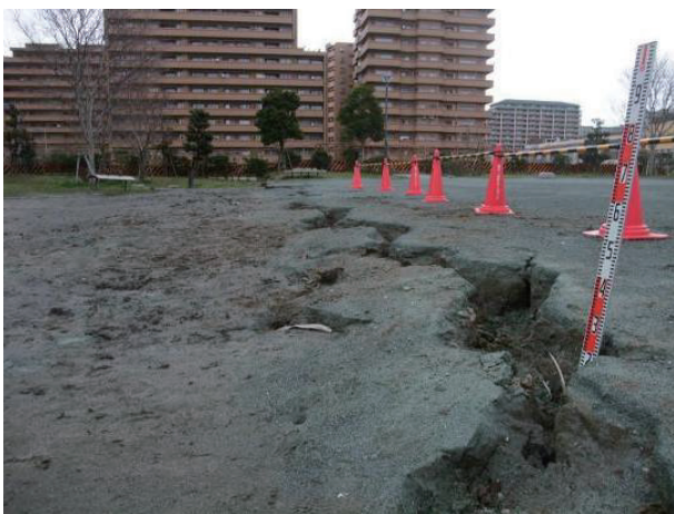
地盤の液状化 - 流動化に伴う地割れ（浦安市明海）.
