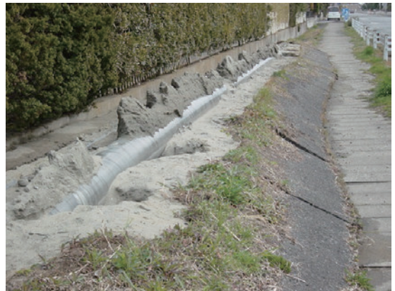
下水道管の被災状況.
