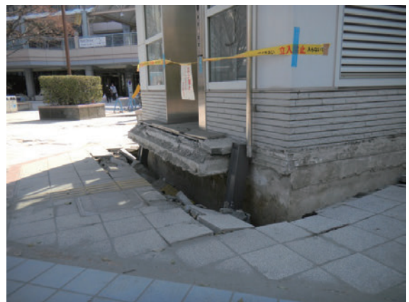
第 2 図 JR 新浦安駅前の地盤沈下（エレベーター入口）。
