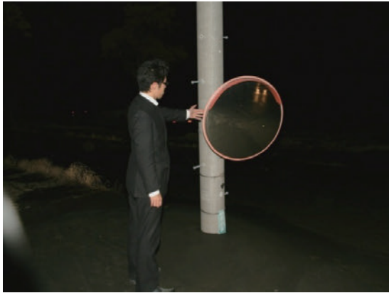
沈下したカーブミラー（電柱）.
