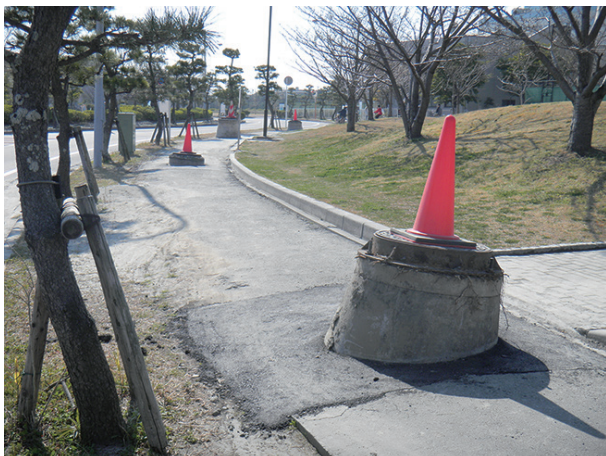
マンホールの抜け上がり（浦安市明海）.
