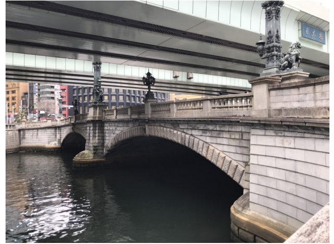
写真9 真壁石・稲田石の両方が用いられている日本橋。
