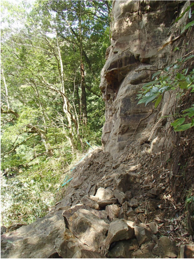
第15図 2019年9月の台風15号で中瀬遊歩道が路肩ごと崩落した現場 崩落地点は、第2図に×印で示しています。左側の約10m下に養老川の河床があります。2019.9.25に南側から撮影。
