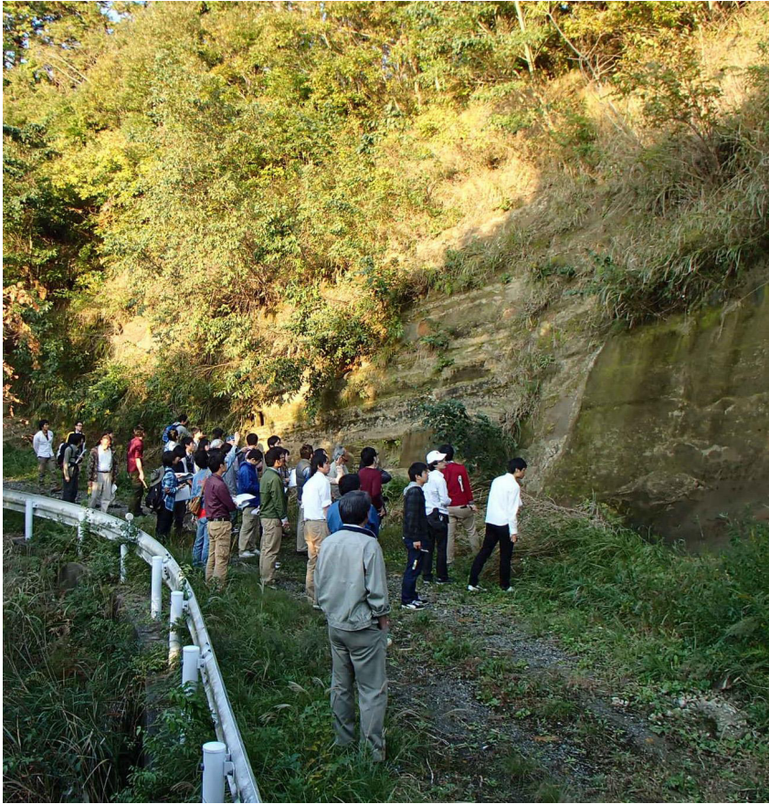
第 29 図 断層の観察 (地点 D) 沢山林道沿いで最もわかりやすい断層で、砂岩泥岩互層 (左手) と厚層理砂岩が高角の断層で接しています。2013 年度 (平成 25 年度) 特別見学会 (地質編) (2013.11.8 実施) にて。
