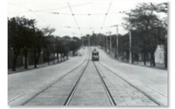
東京市電軌道工事(大正1年)
