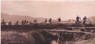
トロッコでの輸送(羽黒駅付近)
