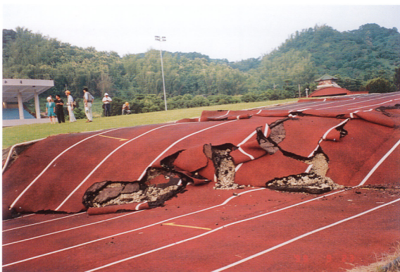
2. 霧峰の光復中学校裏のグラウンドに現れた地震断層の全景(太田撮影).
