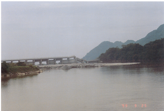
7. 石岡ダムの破壊(太田撮影).
