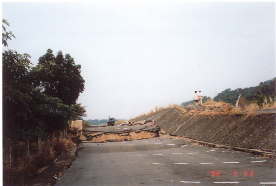
3. グランド南の道路と堤防を変位させる地震断層(太田撮影).
