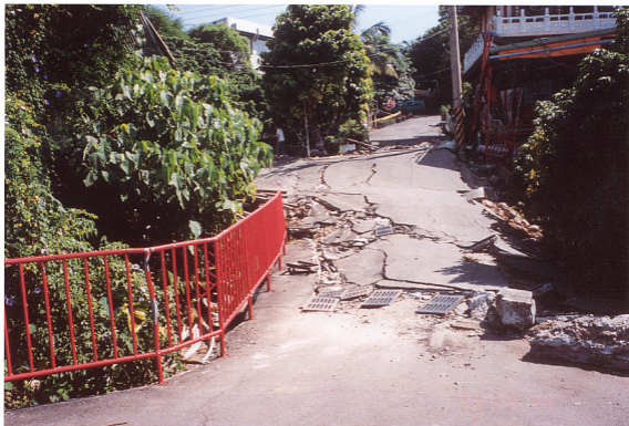
1. 草屯朝清宮北の断層崖を横切る道路に現れた地震断層(太田撮影).
