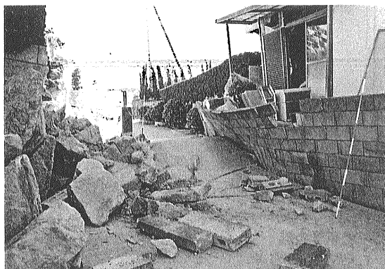
写真83-7 登り坂下部の路面の破断と南隣ブロック塀のはらみ出し(第46図の位置9)[水野 清秀氏撮影(1995.1.27)].
