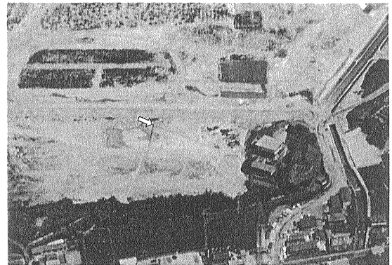
写真80-8 河野 道信氏邸北東側にくっきり見えた活断層。写真80-7の部分拡大。
