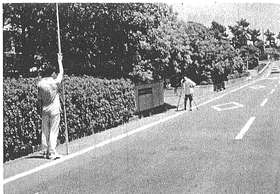
写真2 御前崎での水準測量風景.
