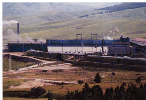
5. 採掘場に隣接する選鉱場。この巨大な建物の中で鉱石は粉砕され、銅鉱物とモリブデン鉱物が分離され、それぞれの精鉱として鉄道で出荷されていく。
