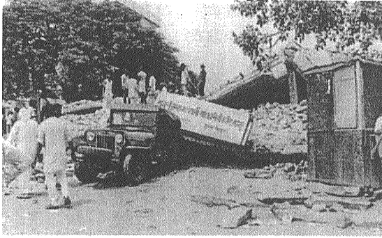
写真5 ラツール地震による銀行の建物の破壊
