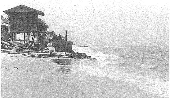
写真6 海岸侵食によって破壊された海浜施設
