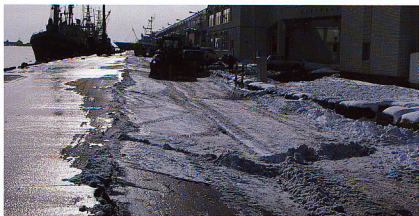
3. 釧路港副港漁業埠頭の地震の翌日の状況。埠頭の両側で岸壁に平行する地割れが連続しその内側の地盤が沈下した。駐車場の路面を縦横に切る地割れと暗色の噴砂が地盤の液状化と不同沈下を示している。埠頭の幅は200m。(写真提供：株式会社シン技術コンサル)
