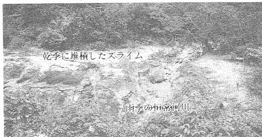
写真5 地表流によって侵食された堆積場。乾季には一面にスライムが堆積するが、雨季に発生する恒常河川によって堆積物質は洗い流される。
