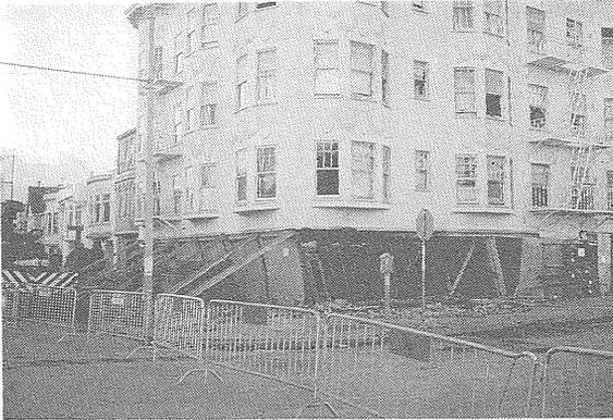
写真10 サンフランシスコ市内マリナー地区の家屋の被害状況。被害は1906年サンフランシスコ大地震後の埋立地に位置し4階建て1階がガレージになっている建物に集中した。
