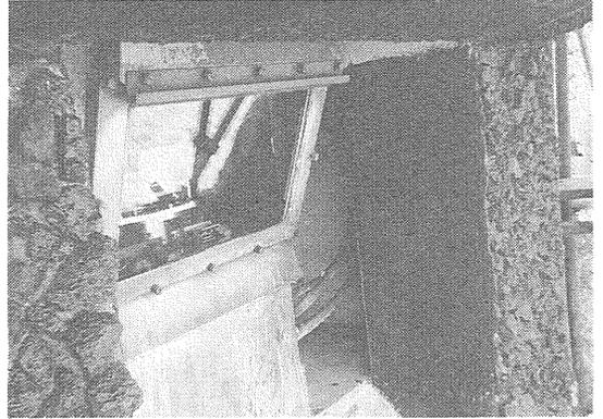
写真2 トーチカの前面。中央ガラス窓の中に火口カメラが設置されている。
