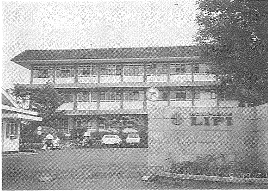
写真 2 地質工学研究開発センター (バンドン)
