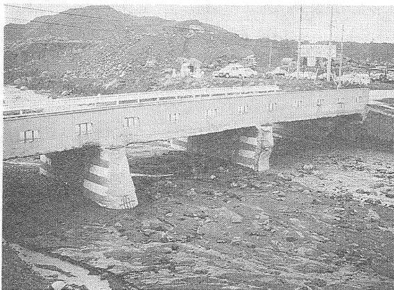
第8図 桜島の南西山麓を流れる野尻川の河口付近。平常時には表流水は認められませんが、土石流発生時にはこの国道の橋の欄干も乗り越えられることがあります。後方の山は海中に流入した土石流堆積物を浚渫して積み上げたためにできたものです。
