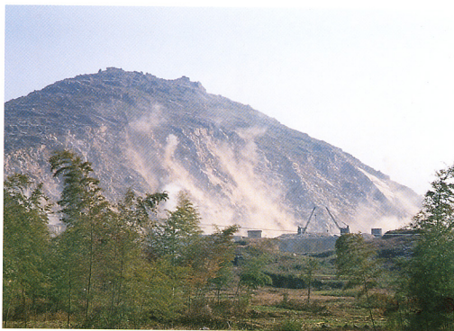
1写真4 蘇州採石場の発破風景。午前の上り発破 爆音が全山をゆるがす。
