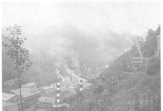
写真15 上東鉱山の化学工場。
