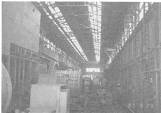
写真14 同 巨大なクラッシャー室。
