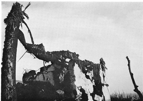
写真13 新瀨池南縁にある休憩所。水蒸気爆発により大小の岩塊が放出され無惨にも破壊されました。左端の木は噴火口側（北側）が著しくささくれ その反対側に折れており噴火口左側から横なぐりに岩塊が飛んできた事がわかります（10月5日午後4時頃撮影）。
