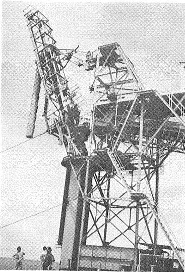
第8図 マムート鉱山が建設した Uskan 港の精鉱船積み機。港にはベルトコンベア 420m・約 1万トン貯鉱場。2000kl 重油タンク等がある。
