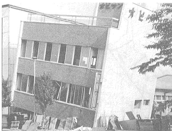
写真1 1階部分がつぶれ傾いたビル
