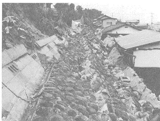
写真2 造成地斜面でくずれ落ちた擁壁
