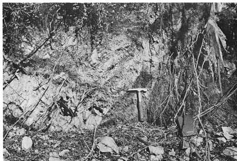
写真3 梁山断層は北部では約200から500mの幅で白亜系砂岩の中に破砕帯を形成し、その中央約10mほどとくに破砕が激しい。本図は写真2の断層谷中の露頭で破砕帯のほぼ中央における主要断層の外観を示す。断層面の走向はN10°E、傾斜は60°W、20°S落ちの滑りあとがあり水平ずれ断層であることを示している。
