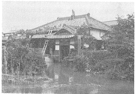
写真3 あたり一面泥水の色と化し 屋根の上で茫然とする市民（竜ヶ崎市姫宮町にて 8月25日午前10時頃撮影）。
