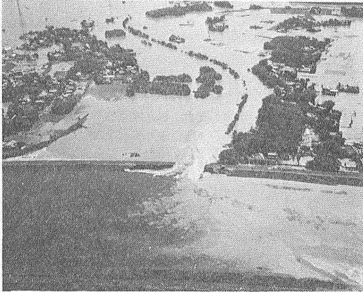
写真1 バックリと大きな口をあけて決壊した小貝川左岸堤防。懸命の復旧作業にもかかわらず 濁流の勢いが強いので開口部がますます拡大して行った(8月24日午前9時頃撮影)。小貝川は上流側(左)に比べて 下流側が利根川の逆流水で混濁しているのがよく判る(太平洋航業株式会社提供)。
