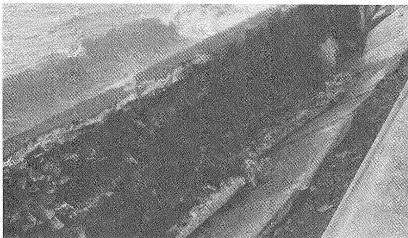
写真6 陥没した旧護岸 (1978年 8月18日 早期) 前年 5月には護岸の海側約15mまで砂浜
