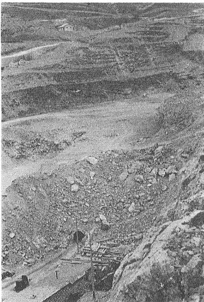
⑫ ブュック鉱山坑口。 エティバンク社により開発中の主要運輸坑道坑口 上位は 露天探掘の跡。
