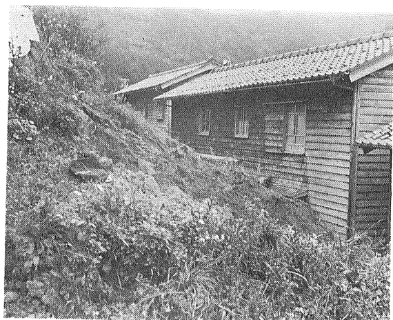
写真10 香住町東部境部落には豊岡層群が発達している 集塊岩質凝灰岩のうち 土壌化した部分が部落のうらまで崩壊し 生活をおびやかした 47.10
