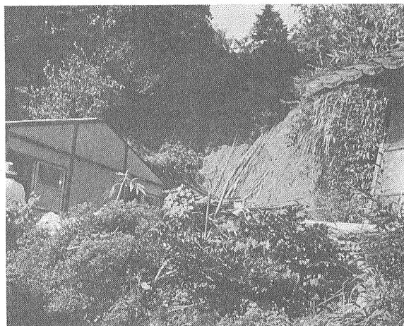
写真⑯ 日指のがけくずれの一部 真下の家は倒壊した 手前は仮設住宅
