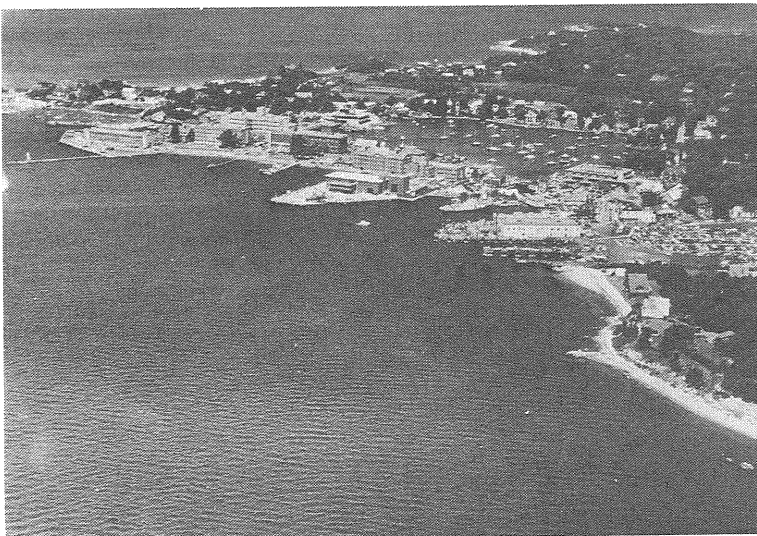
① ウ ヅ ホ ー ル 海 洋 研 究 所 全 景
