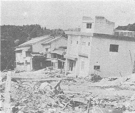
写真⑭ 土台を洗掘されて傾むいた旅館(湯田温泉)
