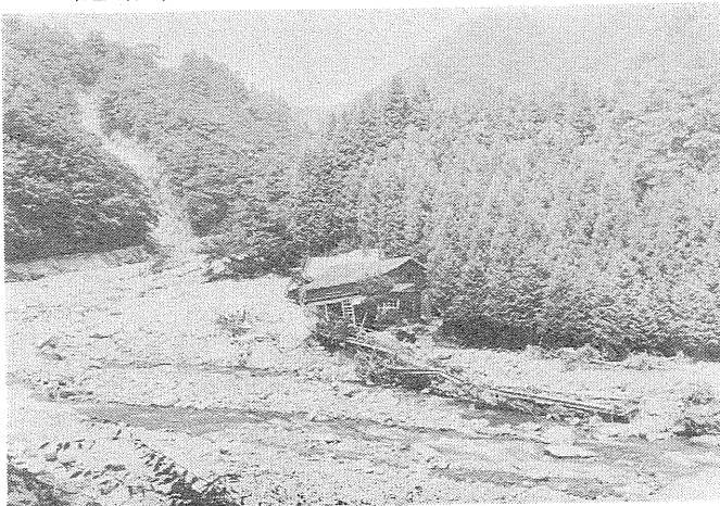
⑭ 河原としたキャンプ場 中川川本流の濁流と背後の谷からの土砂の押出しによってバンガローは流失した。母屋だけが傾むきながら 辛うじて残った。(中川川 箒沢の上流)
