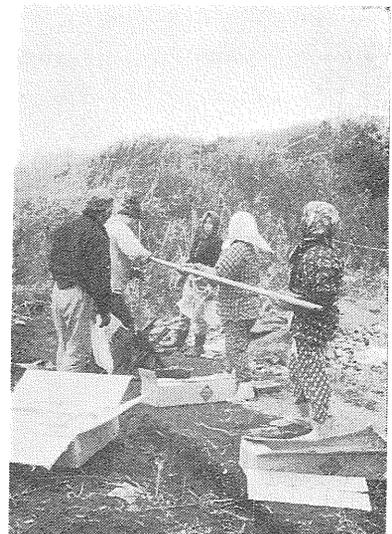
写真①：爆破孔にダイナマイトを装てんしているところ。 込め棒で突いて押し込む。 手前の箱の中に入っているのがダイナマイト。
