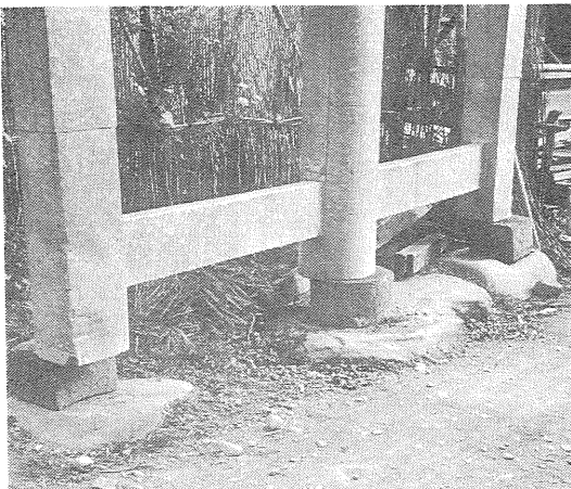
写真11: 岩井川山神社の鳥居。 台石から東方(左)へずれた。 手前の1つは 台石の方がより大きく東方へずれた。
