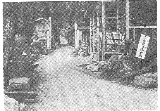
写真10: 岩井川山神社のこま犬。 東方(右側)へずれた。 左手前“へそ”のある石碑も倒れた。
