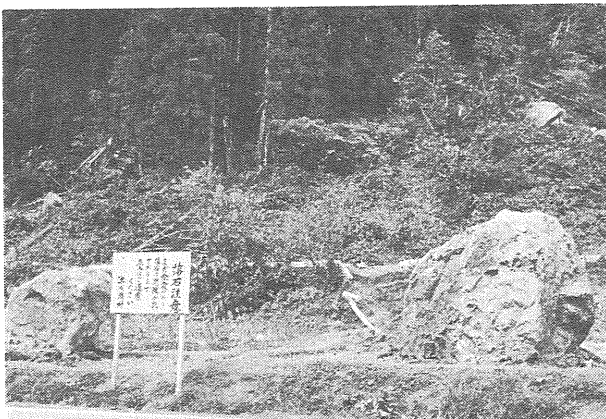
写真2：田んぼの中に落ちた数10トンの安山岩質凝灰角礫岩の巨大なブロック。ほかのものは復旧しても、この大石だけは地震の“象徴”として残りそうである(岩井川一肴沢間)。
