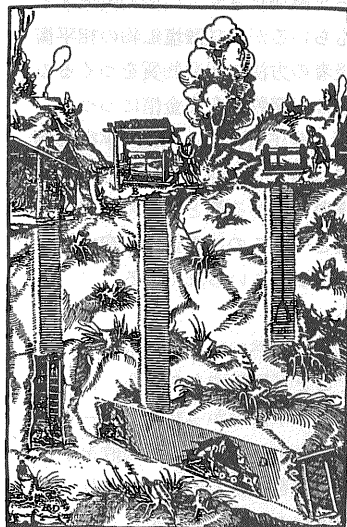
第8図 デレメタリカ中の採鉱の様子 たて坑、斜坑や探掘の状態がよくみられる。まきあげで鉱石およびずりを地表へはこびだしている
