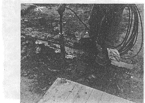
図20 間隙水圧計の設置作業
